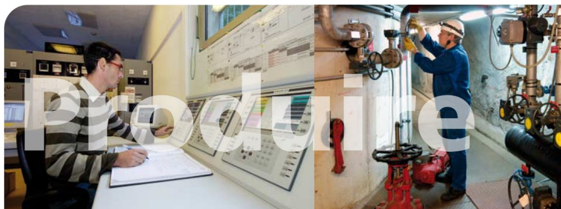
Figure 90 : Usine hydroélectrique de Revin
